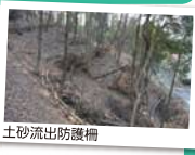
土砂流出防護柵
